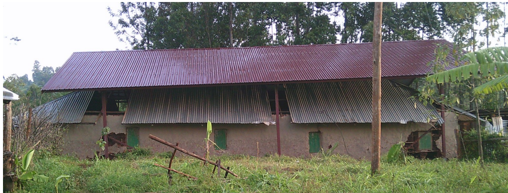
Tagkonstruktionen til den nye kirkebygning er færdig.
